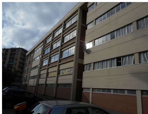
Figura 0.1 - Vista della facciata [esposta a Sud-Est]
