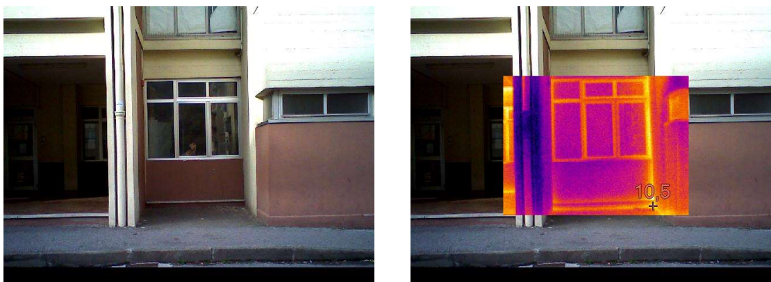
Figura 4.7 – Rilievo termografico dei serramenti
