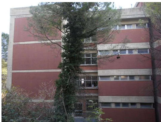
Figura 4.2 - Particolare della facciata retrostante
