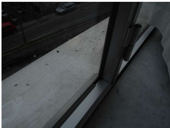
Figura 4.5 - Particolare dei serramenti – dettaglio angolo vetro degli infissi a singolo vetro
