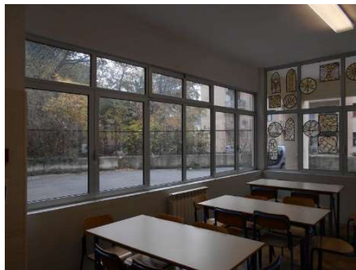
Figura 8.5 - Particolare infissi di un aula
