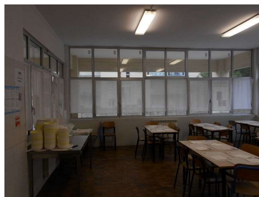
Figura 4.15 - Particolare dei corpi illuminanti ubicati nelle aule scolastiche
