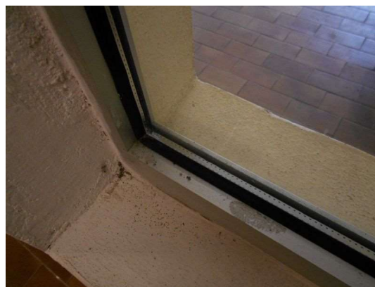
Figura 4.6 - Particolare dei serramenti – dettaglio angolo vetro degli infissi a vetro doppio
