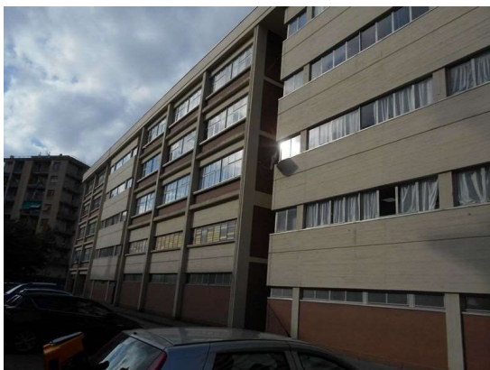
Figura 4.1 - Particolare della facciata principale
